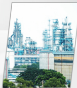
工業設備加工服務 土木関連
